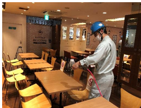
▲テーブル・椅子への施工
